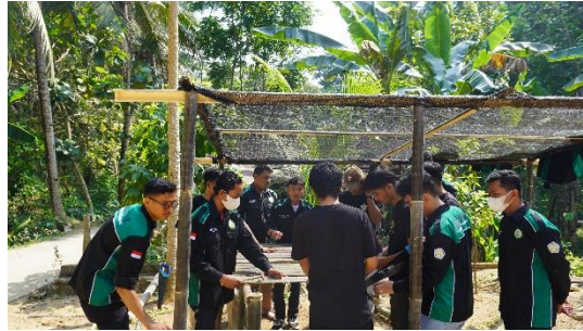
Gambar 2. Pembuatan bangunan paranet
